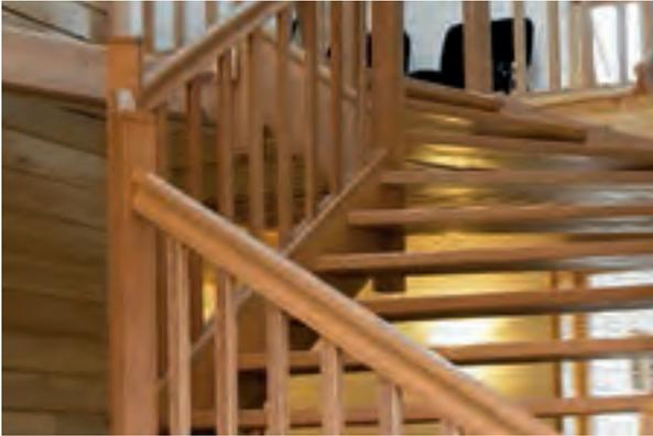
**TIPP** Selbstverständlich sind auch mit Leisten schräge Verbindungen möglich, die gerade bei Treppenauf- bzw. abgängen nötig sind. Hierzu stellen Sie an der DOMINO Dübelfräse beim Fräsen in die Leiste den Schnittwinkel der Leiste ein (über die Fräswinkeleinstellung) und fräsen Sie das DOMINO Fräsloch.
